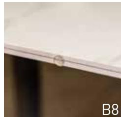
**B8.** Appliquer des renforts en silicone verticalement et horizontalement sur les montants de la paroi de douche dirigés vers le sol.
