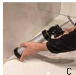
En alternative, la paroi de douche Kerbon peut être fixée au sol à l'aide d'une colle de montage appropriée. Pour ce faire, utiliser un adhésif adapté au support et suivre les instructions du fabricant de colle.
